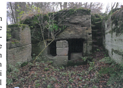
Ve vstupu do podzemní části mlýna na hrázi Dolanského rybníka je vidět vybrání pro hřídel mlýnského kola o průměru 60 centimetrů
